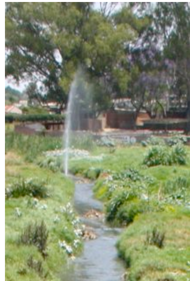
Leck in der Frischwasserzuleitung unter einem Abwasserkanal
